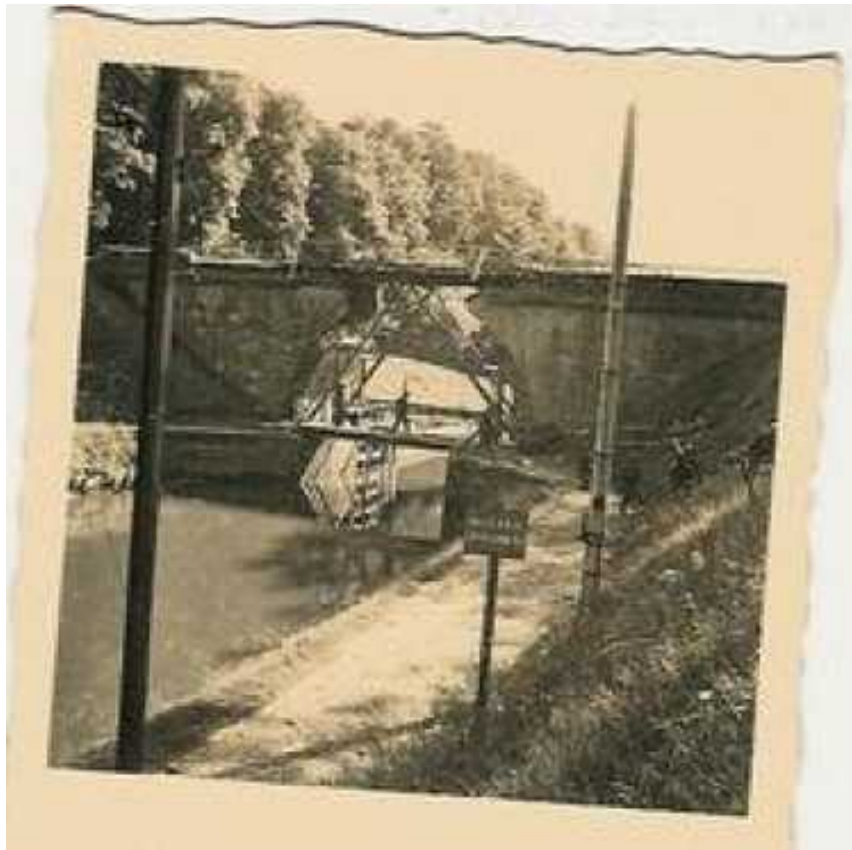
Destructions facilement réparées sur le Canal de la Marne au Rhin quelque part entre Réchicourt et Xouaxange, zone d'action de la 60 ème ID
